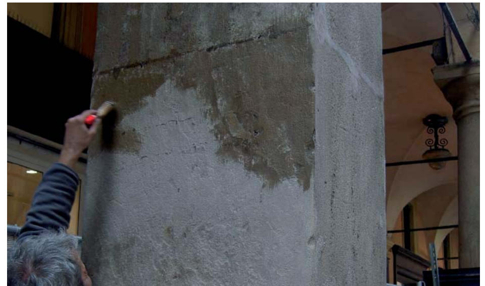
Stesura del trattamento protettivo
