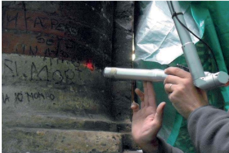
3. Rimozione del vandalismo con tecnologia laser
