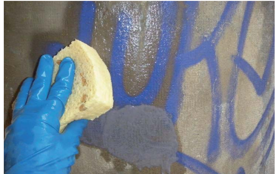
2. Rimozione con rimotori antigraffiti o con solventi addensati
