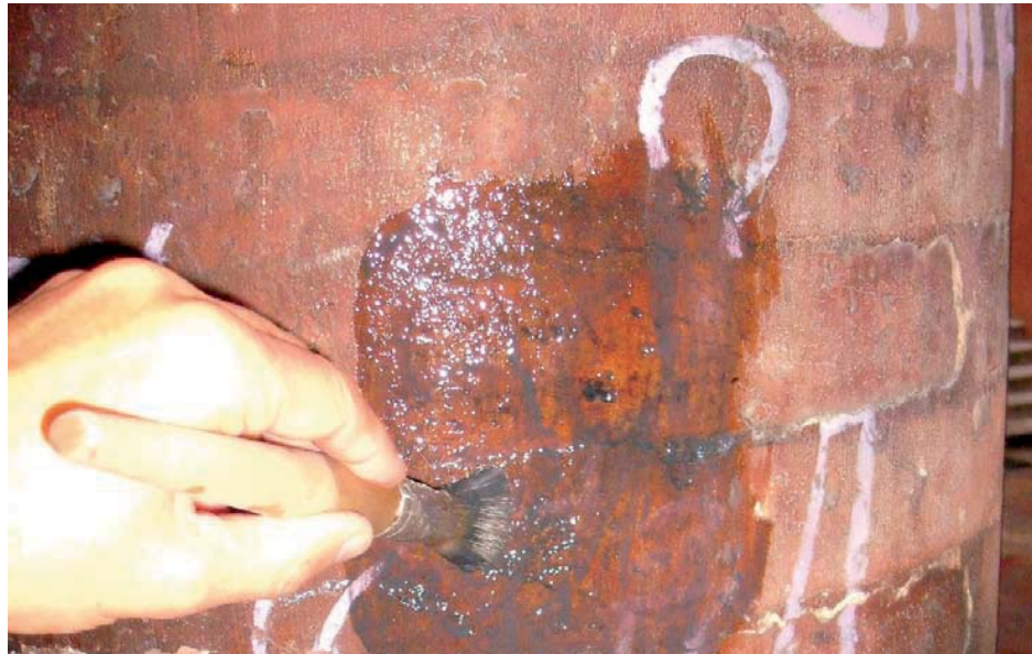
1. Applicazione di rimotori antigraffiti o di solventi addensati
