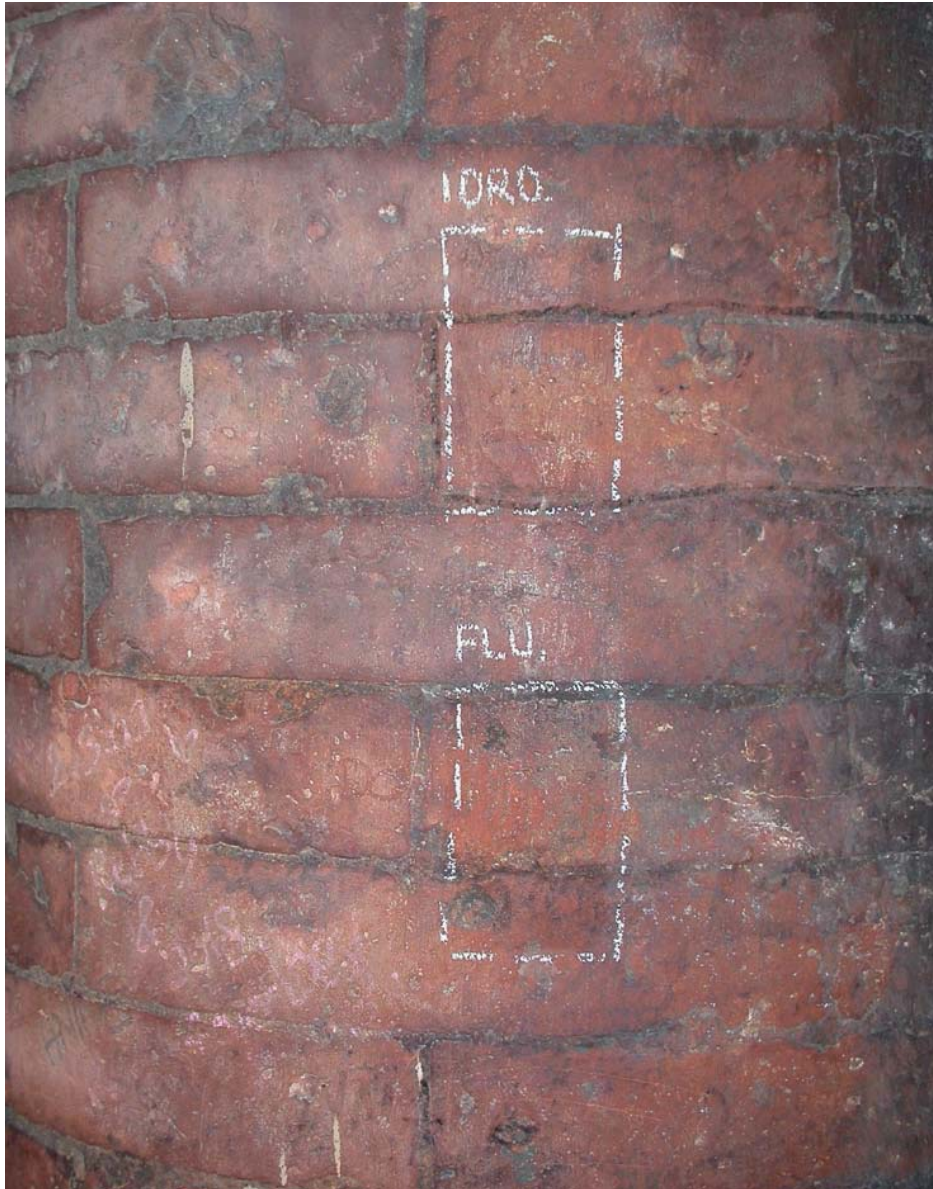
5. Prove preliminari in situ del trattamento protettivo
