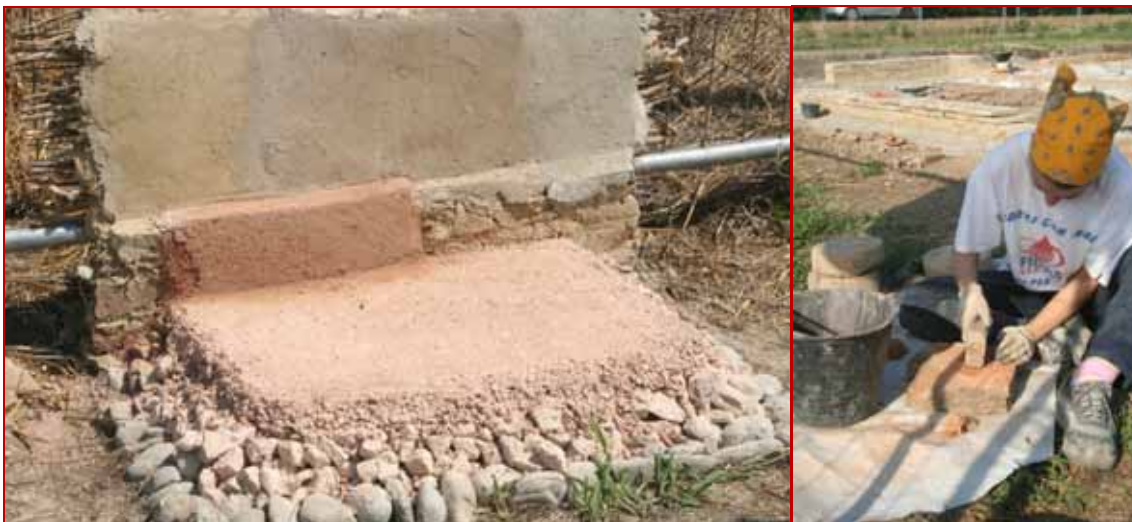
Prove di posa del pavimento, intonaco in calce e cocchiopesto, intonaco in terra e paglia sul graticcio (a sx) Una studentessa frantuma il laterizio per ottenere il cocchio pesto (a dx)
