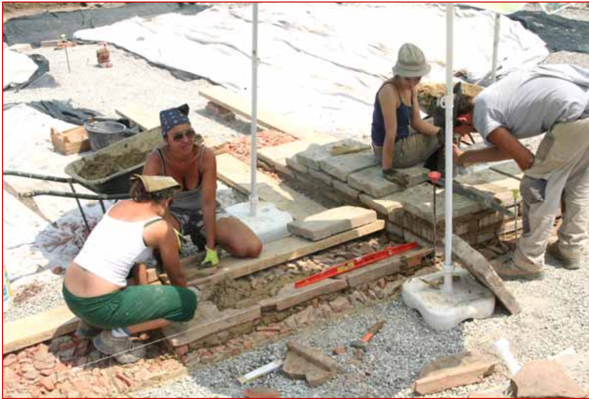
Costruzione delle basi murarie: a sx in porzioni di tegole; a dx in mattoni sesquipedali
