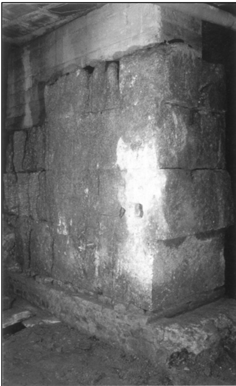
Fig. 9. Muro radiale di età imperiale in blocchi di selenite
