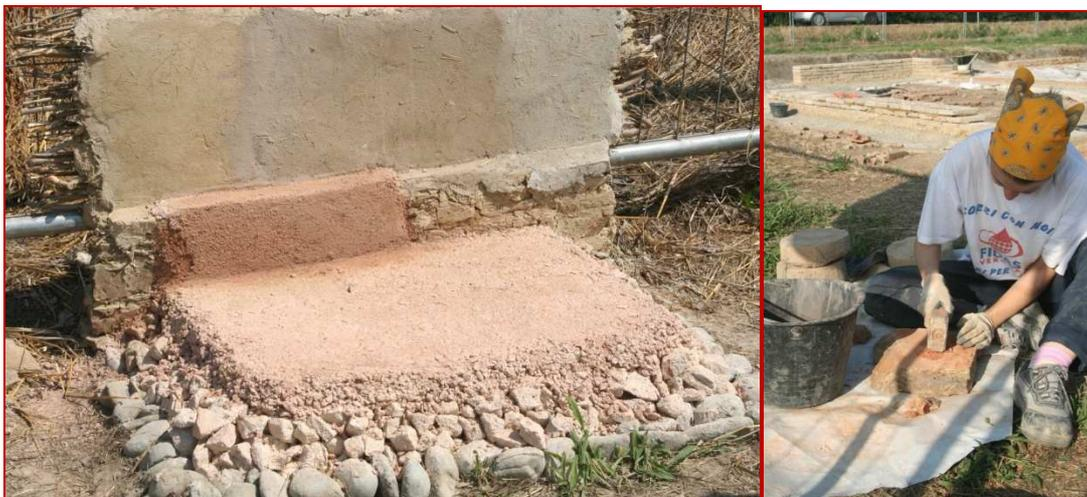
**Prove di posa del pavimento, intonaco in calce e cocci pesto, intonaco in terra e paglia sul graticcio**
